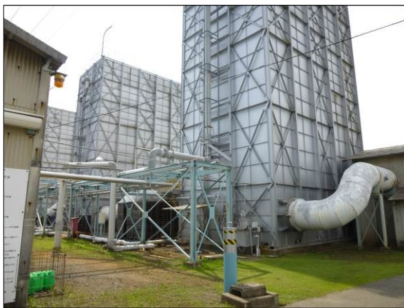
ブローアウト用の放散塔
