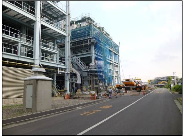
手前が現在の炭化炉、奥は新設中の炭化炉
