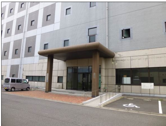
見学者説明室のある第一汚泥処理棟
