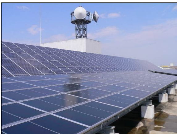
A館の屋上の太陽光発電パネル
