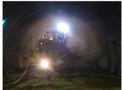
トンネル現場にて 貫通後、後光が射す瞬間
