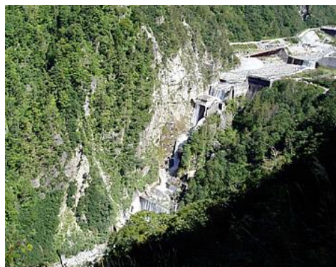
白岩砂防堰堤
